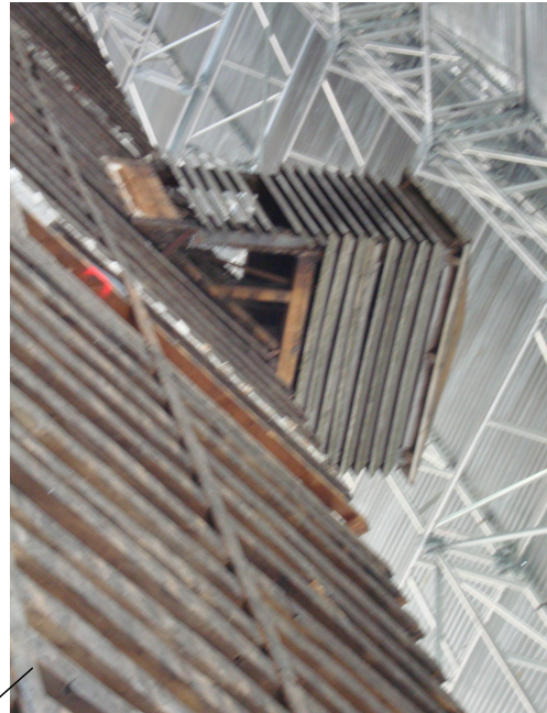
Linteau dans un état de détérioration
